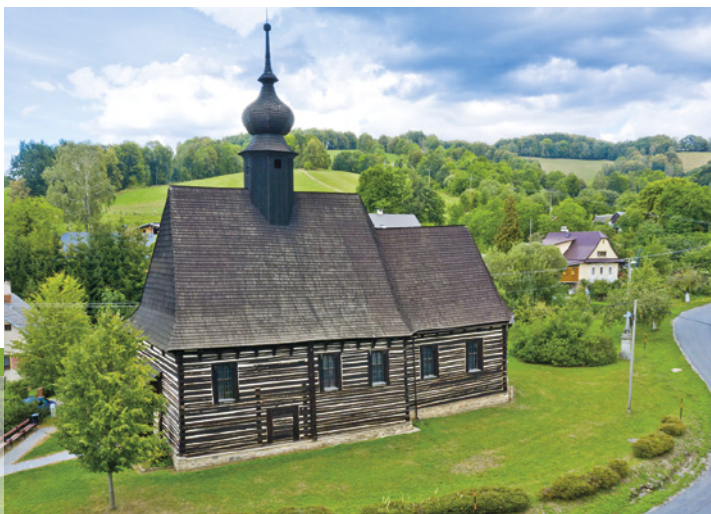
Dřevěný kostel v Maršíkově
